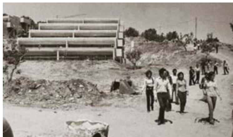
I lavori per edificare l'Università della Calabria
